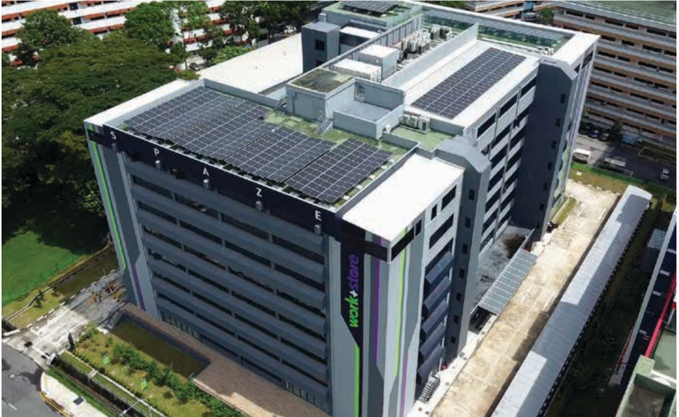
202 Kallang Bahru屋頂上的太陽能板
